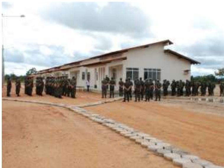
Imagem dos PNR do 2º BIS/1º Pel. Esp. Front, construídos pela COMARA e inaugurados em 21/06/2011
