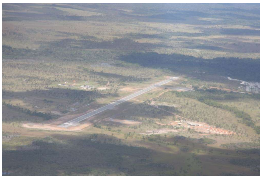
Imagem da pista de Tiriós/PA (2.000X30M), construída pela COMARA e inaugurada em 21/06/2011, com as instalações do DCTA-TS (à esquerda) e do 2º BIS/1º Pel. Esp. Front (à direita)
