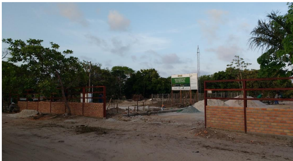
Figura 14 – Entrada do novo escritório do ICMBio do PNLM Fonte: Ruan Tavares (2016)
