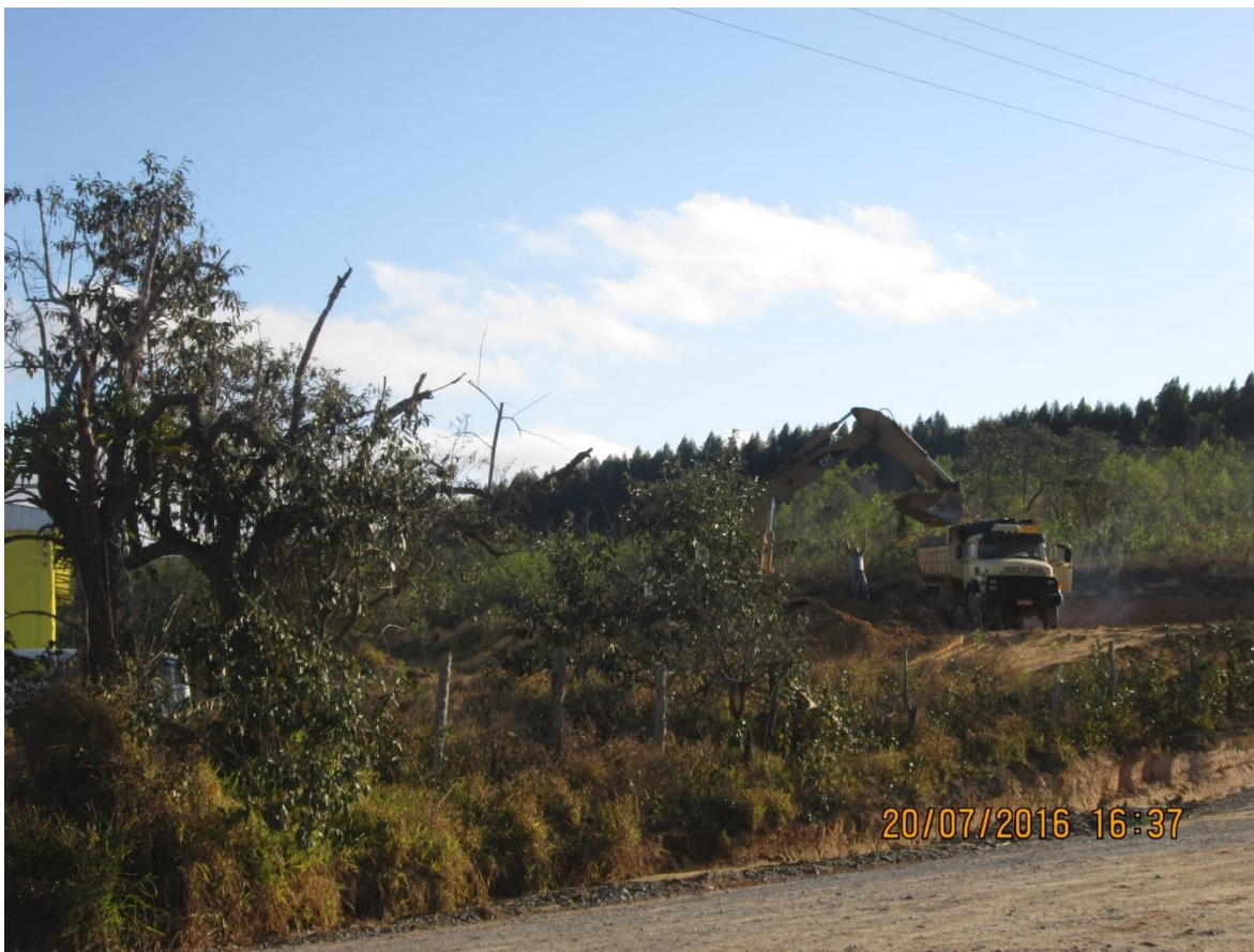
Figura 19: Construção da futura pousada do Cafundó
