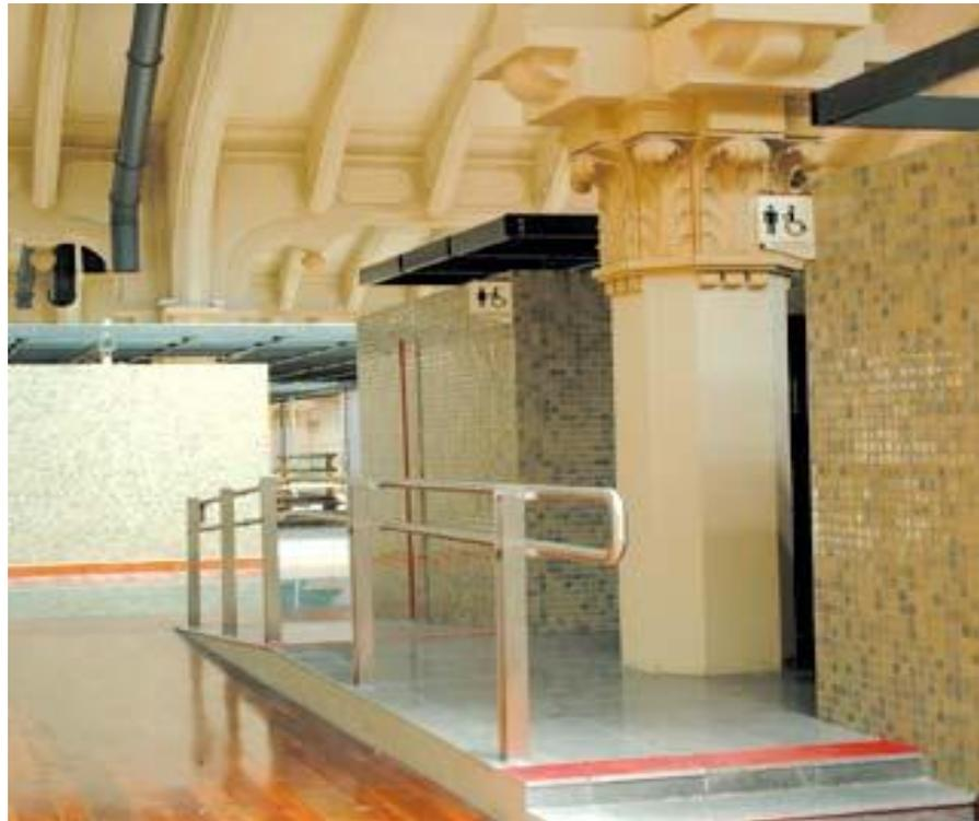
Fotografia 25: Sanitários construídos no mezanino com acesso a deficientes
