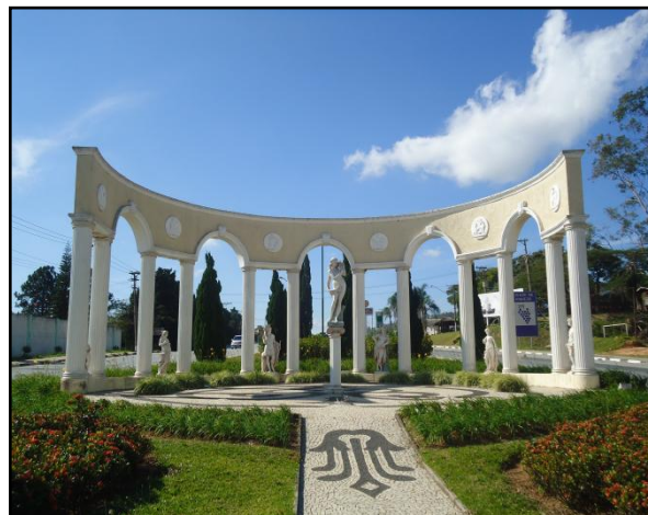
Figura 29: Rotatória no acesso principal de Vinhedo Fonte: Autora (2012)
