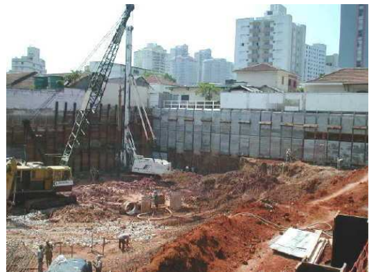
Imagem 12: Escavação prédio 5 Fonte: Construtora Racional.
