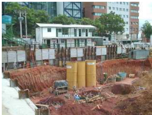
Imagem 11: Construção do prédio 5 Fonte: Construtora Racional.
