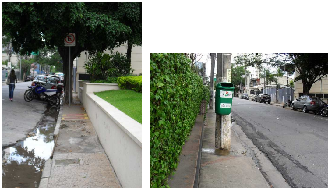
Imagens 36 e 37: Rua Alvorada esquina com Rua Gomes de Carvalho. Fonte: Arquivo pessoal (2013)
