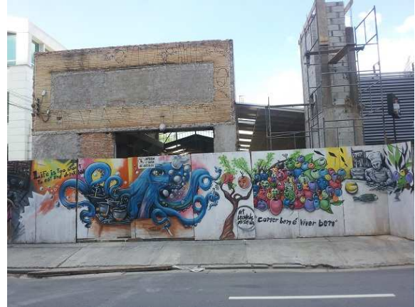
Imagem 25: Reforma para instalação do Empório Eat... Fonte: Fábio Seabra, 2011.
