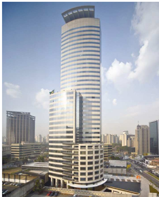
Imagem 19: E-Tower Vila Olímpia Fonte: CBRE, 2010.
