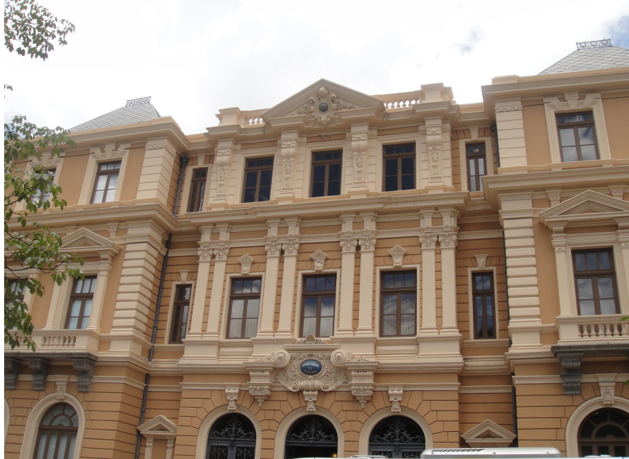
Figura 12: Fachada do Memorial Minas Gerais – Vale Fonte: Própria
