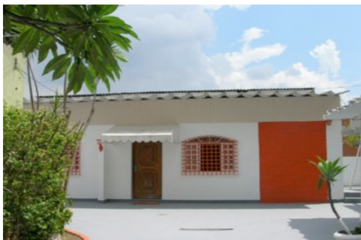
Figura 12 – Fachada do Sampa Hostel
