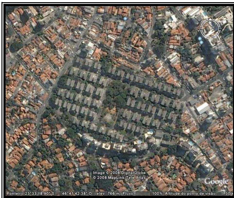
Foto 6 – Vista aérea do Conjunto Residencial Natingui.
