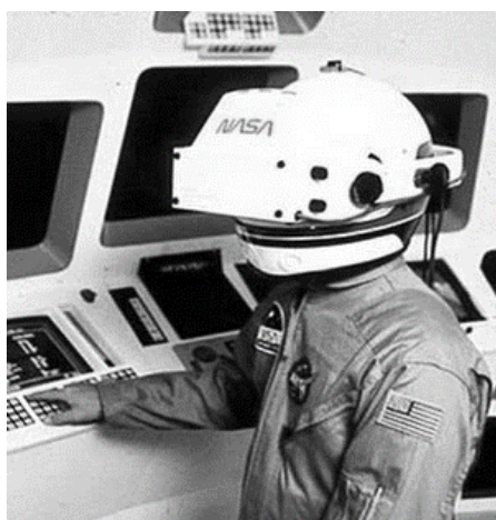
Fig. 42: sistema VIVED, o primeiro HMD criado pela NASA (1984) 90 .
