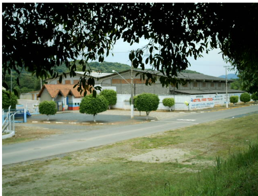
Figura 48 – Muro externo do Centro de Eventos de Pariquera-Açu. Fonte: O autor (2005)
