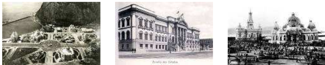
Figura 2 – Visão Panorâmica do Palácio dos Estados e construções individuais, em 1908. Fonte: REPÚBLICA ONLINE, 2006.
