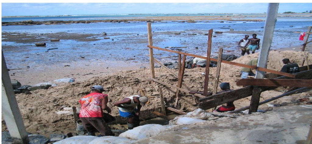
Fotografia 50: Construção da nova ponte. Fonte: Azevêdo, 2004.
