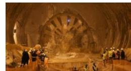
Figura 1: Megatatução em funcionamento
